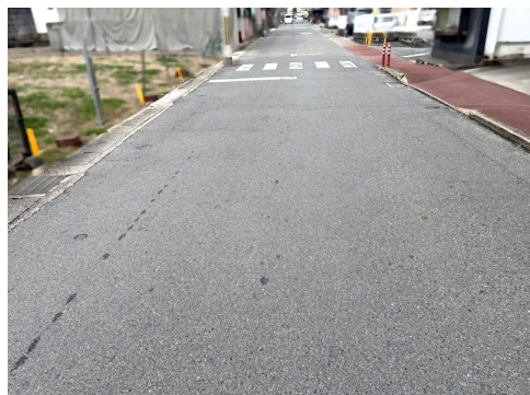
現況上物:木造瓦葺垂鉛メッキ鋼板2階建 / 建築面積:1階85.2m 2 /2階71.23m 2 延床156.43m 2
