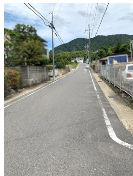
宅地造成工事規制区域
