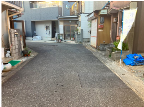
連棟を切り離しております。隣家の補修作業は売主にて行います。
