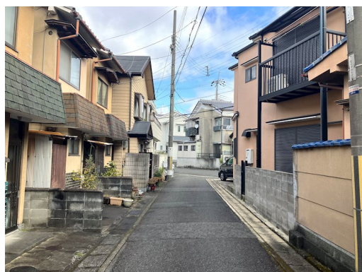
前道非道路につき再建築不可
